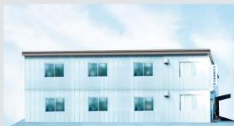
小型変圧器工場
